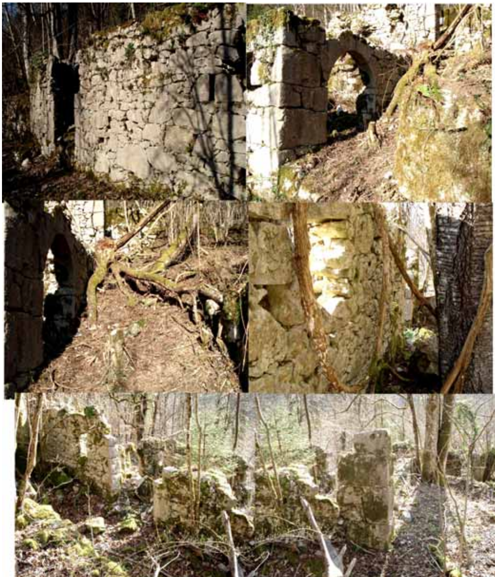
Radiodelavnica na Novi gori 2015: spredaj, z desne s stopnicami proti vhodu, pred vhodom v zgornjo etažo, ostanki zgornje etaže
